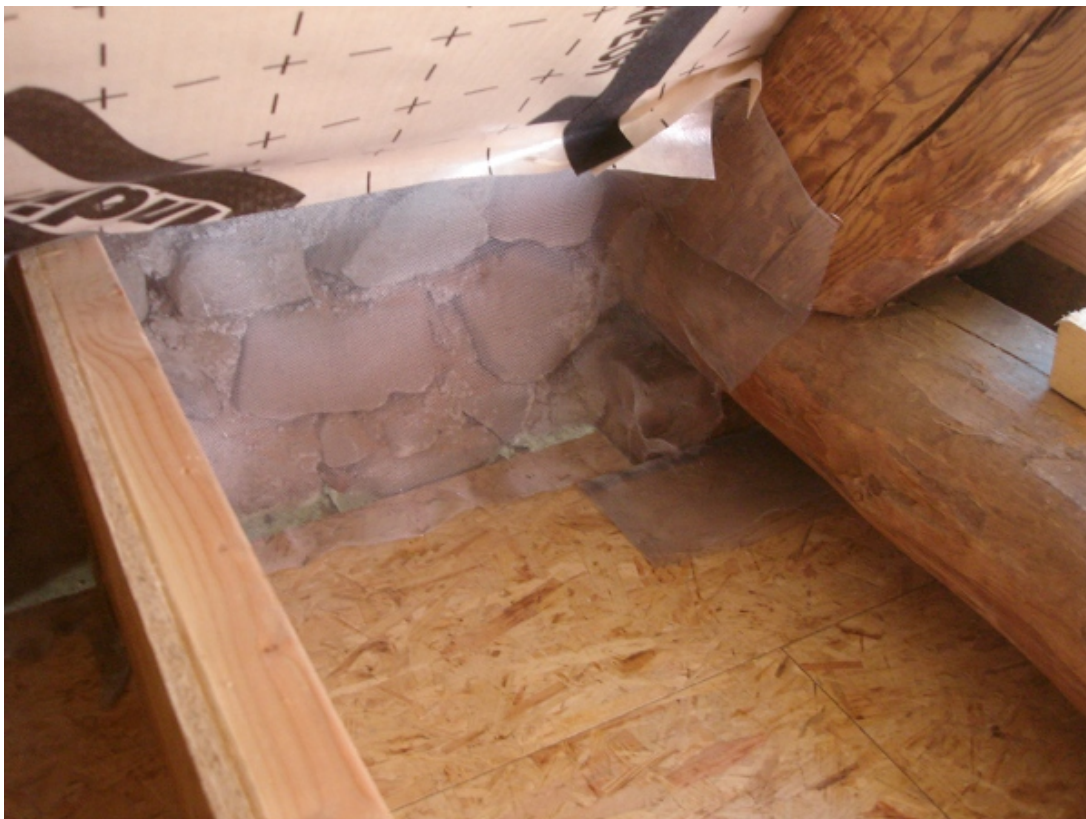
Renfort de la dalle en bois
