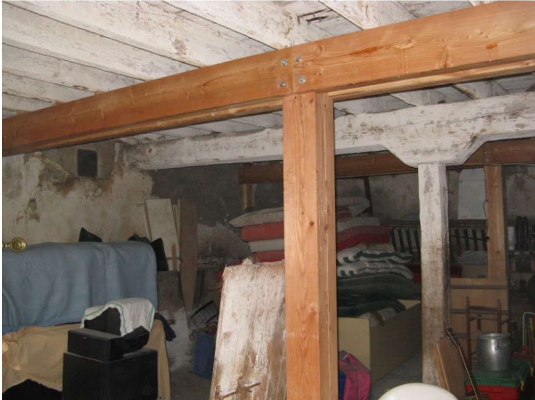
Renfort de l'étage inférieur
